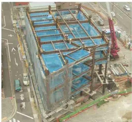
▲ 日比野学舎工事
