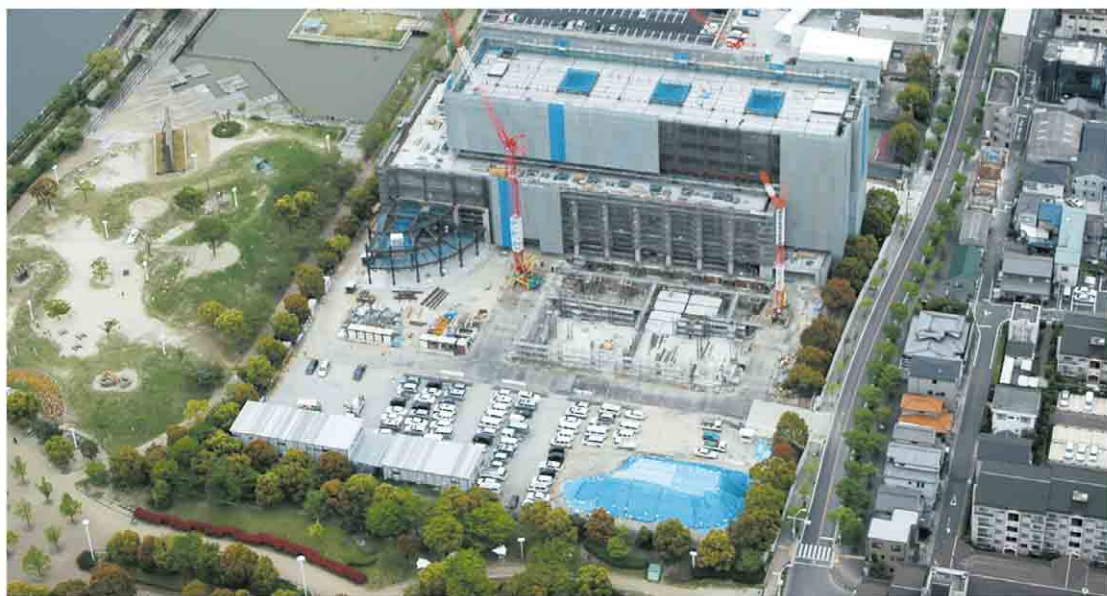
▲ 白鳥学舎工事
