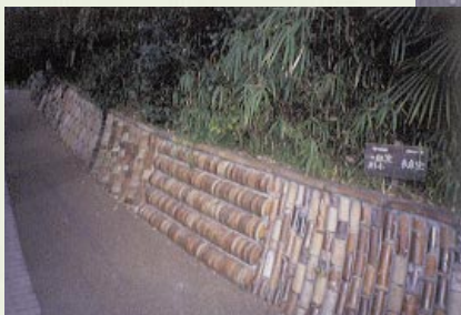
修復された新しい窯垣
